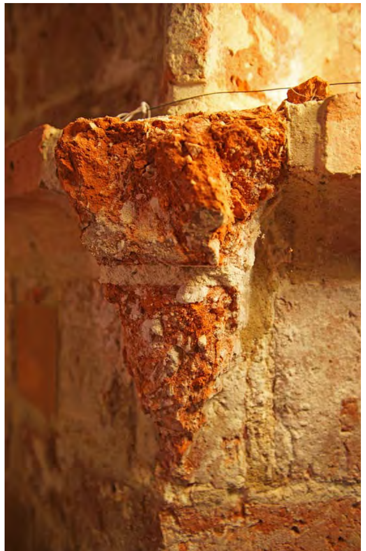
Oben: Im Oxsenkeller. Eine der völlig zerstörten Gewölbekonsolen.
