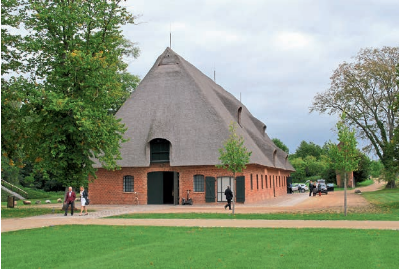
4 Sanierte Gutsscheune (ehem. Jungviehstall) auf Gut Weissenhaus.
